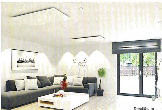
Die an der Decke montierten Infrarot-Heizplatten erzeugen Strahlungswärme und sorgen so für wohlige Wärme bei moderaten Temperaturen. Die Temperaturen sind auf allen Oberflächen (Boden, Decke und Wände) nahezu identisch. Weil anders als bei herkömmlicher Heizung keine Luftverwirbelungen stattfinden, ist die Raumluft fast staubfrei – bei geringem Energiebedarf.
